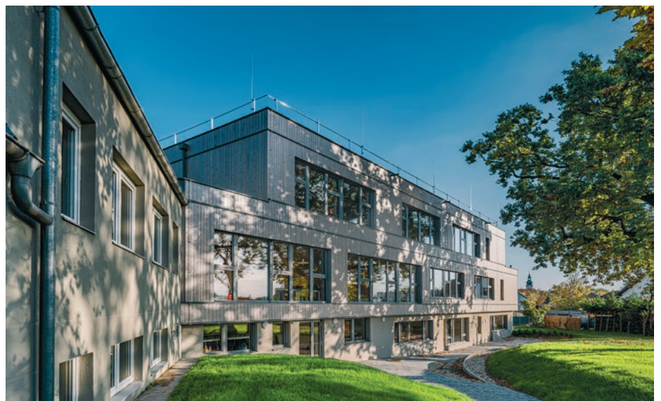
Optimaler Material-Mix aus einer Hand: In Moosbrunn (Niederösterreich) wurde ein Volksschulgebäude in gemischter Fertigteilbauweise erweitert. Mit Doppelwandelementen und Elementdecken wurde der Keller mit Beton, sowie die darüberliegenden Geschosse mit einer Kombination aus Holz und vorgefertigten Holz-Beton-Verbundelementen realisiert.
