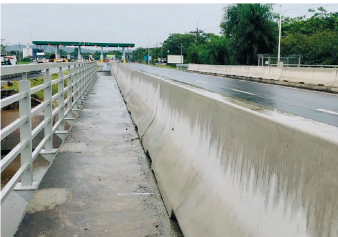
Megaprojekt in Paraguay: 113 km (!) Deltabloc®-Elemente wurden seit 2018 an der Ruta del Este in Richtung Brasilien installiert.
