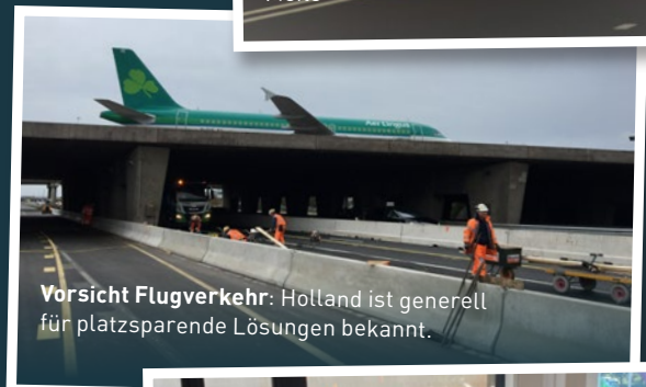
Stadtbrücke Nijmegen (2012): Ein wichtiger Meilenstein für DELTABLOC Nederland.
