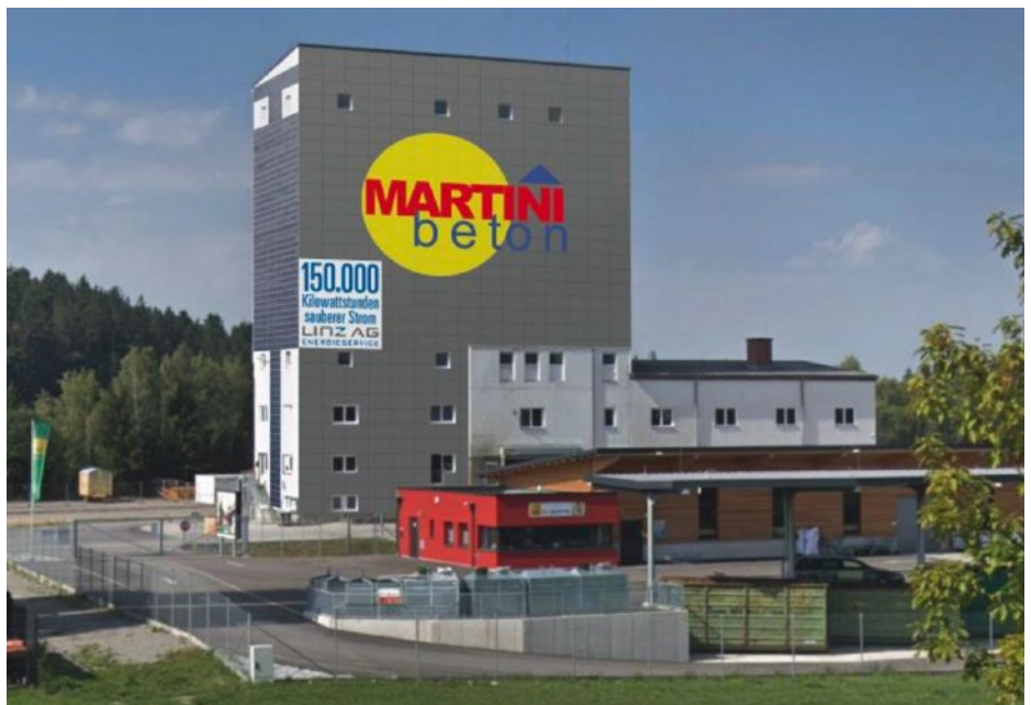
Photovoltaik-Leuchtturm im Mühlkreis: Die Mehrkosten gegenüber einer konventionellen Putzfassade amortisieren sich (abzüglich der erhaltenen Förderungen) schon in wenigen Jahren. Die Einsparung von Energiekosten über die geplante Nutzungsdauer von 30 Jahren bringt nahezu die Gesamtinvestition der Fassadenrenovierung herein.
