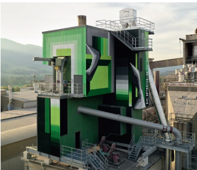
Die als Ersatzbrennstoff eingesetzte Leichtfraktion wird am Weg durch das 40 m hohe Steigrohr vorgetrocknet und gefiltert (Bild links) und danach über einen separaten, sogenannten Satellitenbrenner in das Drehrohr eingeblasen. Bild rechts: Drehofen Hauptbrenner mit separatem Satellitenbrenner (das kleinere, betonummantelte Rohr auf der rechten Seite).
